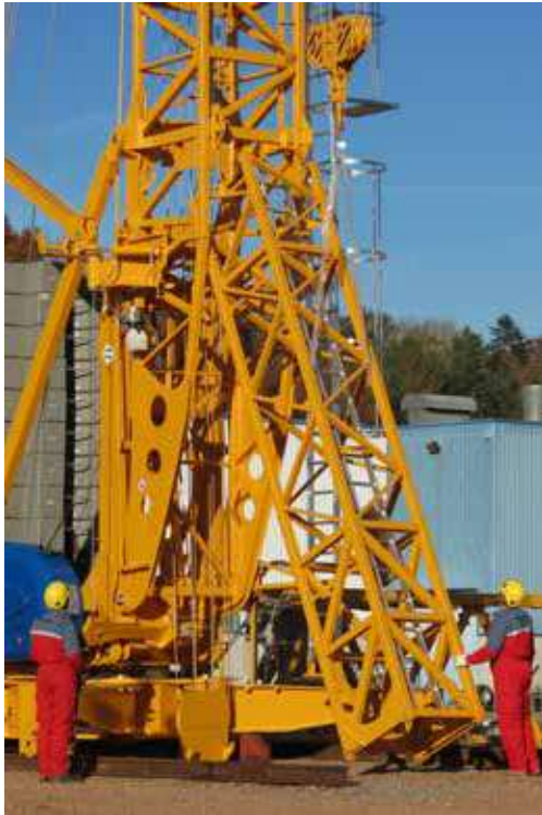
^ Télescopage par insertion de mât rallonge
